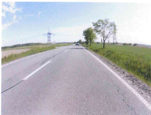
Podélné rozvětvené trhliny
