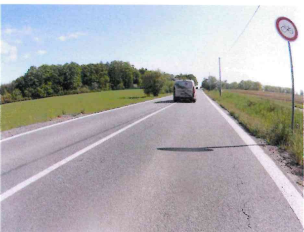
Podélná trhlina
