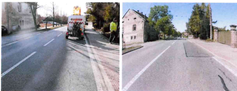
2020 (mozaikové / síťové trhliny, deformace), 2022 (síťové trhliny – vývoj před a za výpravkou)
