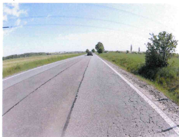
Síťové trhliny
