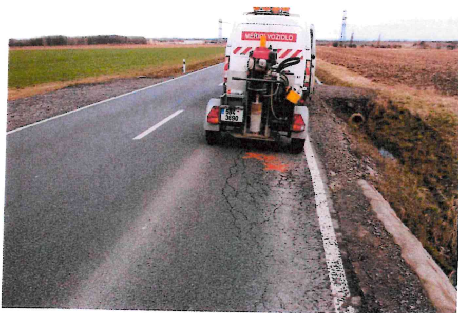
Obr.4: Mozaikové trhliny (stav k únoru 2020)
