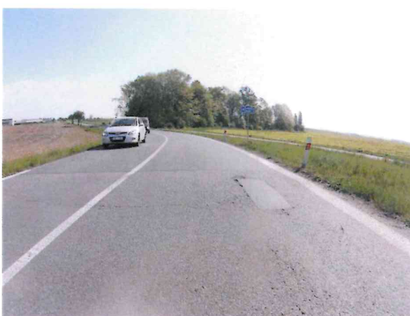
Konec úseku, mozaikové trhliny, vyspráva
