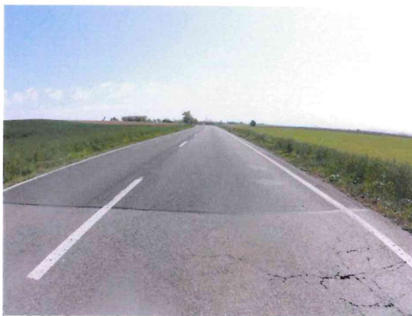
Konec úseku, výtluk, mozaikové trhliny
