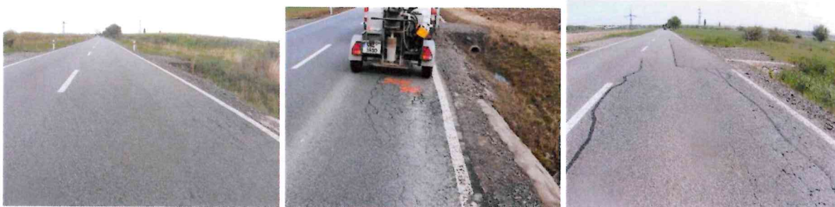
2019 (mozaikové trhliny), 2020 (síťové trhliny, deformace), 2022 (síťové trhliny, deformace, nová vysprávka)
