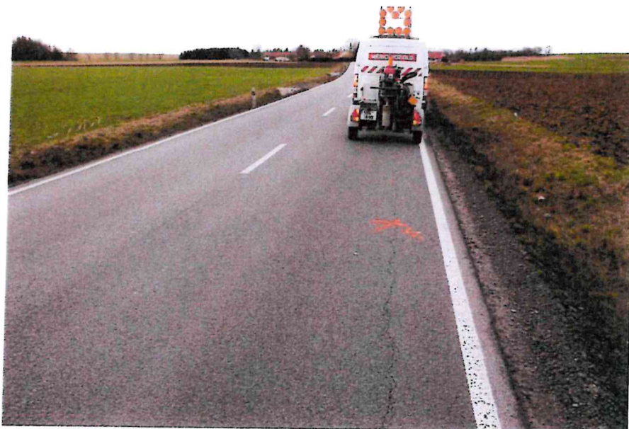
Obr.7: Podélná trhлина (stav k únoru 2020)
