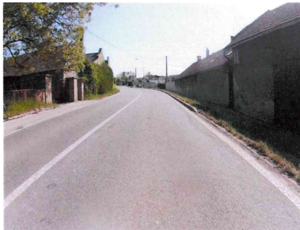
Podélné trhliny
