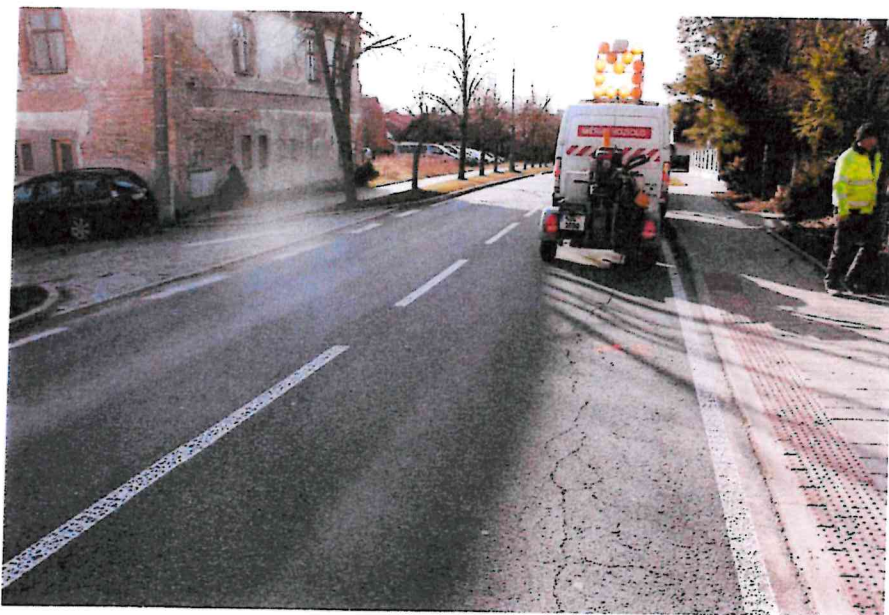
Obr.9: Mozaikové (síťové) trhliny (stav k únoru 2020)
