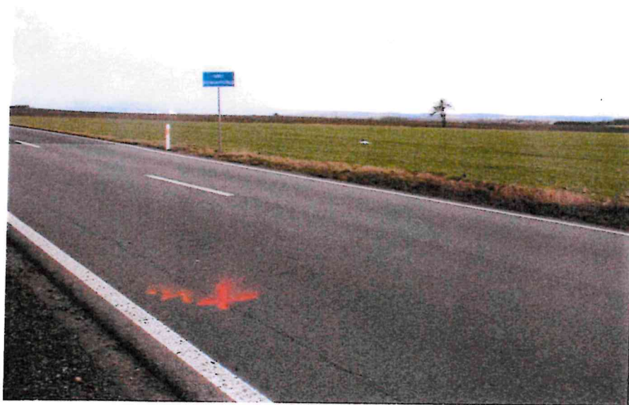
Obr.8: Podélná trhлина (stav k únoru 2020)
