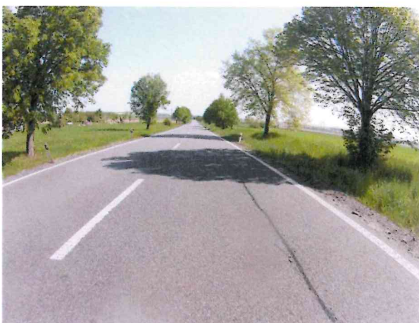
Podélná trhlinka
