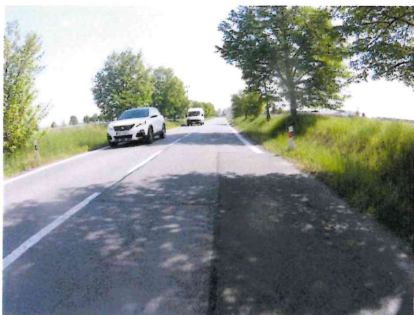
Začátek úseku, mozaikové trhliny, vysprávka
