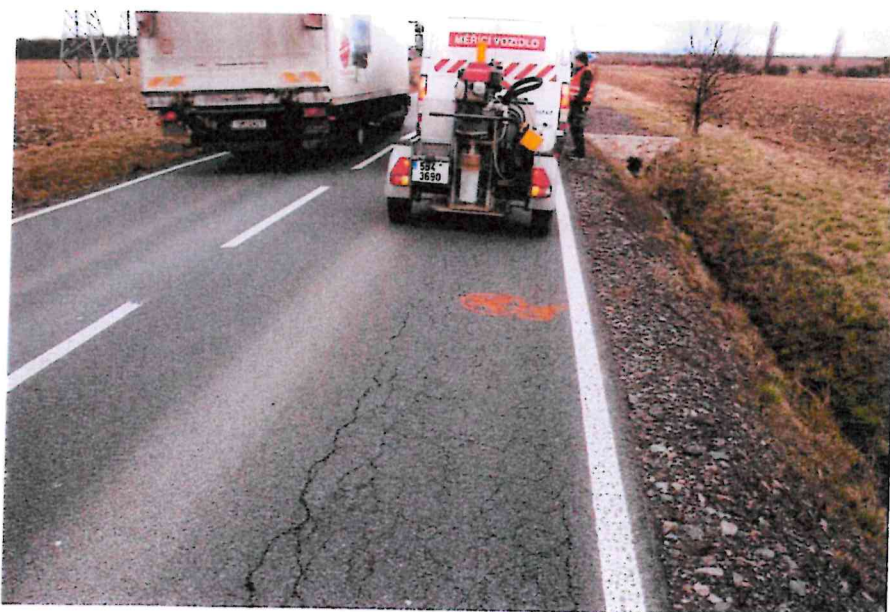
Obr.6: Mozaikové (síťové) trhliny (stav k únoru 2020)
